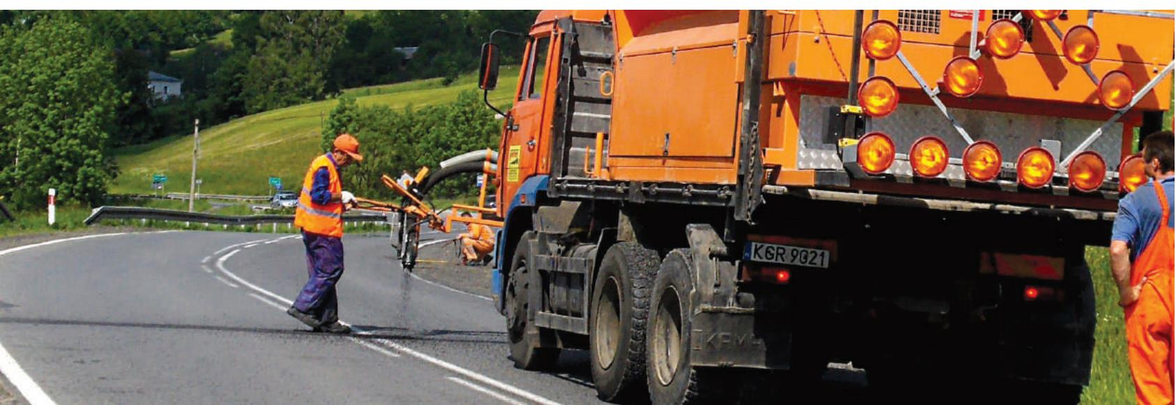
Основна предност на **STRASSMAYR STP 1008**, машината за поправка на патишта/закрпувач, е овозможување на репарирање/крпење на дупки и оштетувања на патиштата без користење на глодалка за асфалт и финишер.
