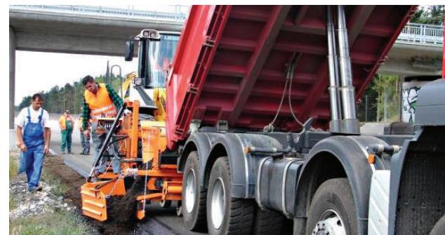
2. STRASSMAYR BF 290 монтирана на трактор со дополнителен хидрауличен проток - градски пат покрај Минхен, Германија.
